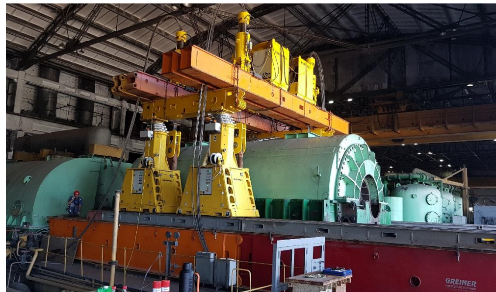
Перемещение и подъём оборудования в сборе без остановки производства
